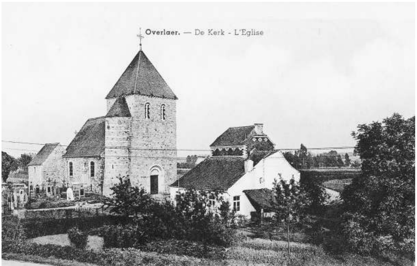
Het Romaanse kerkje (Xe tot XXe eeuw) van Overlaer met de verwerking van Romeinse dakpannen uit de villa van de goudberg in de zijmuren tussen de onregelmatig gekapte kwartsiet en stukken gobertangesteen.
