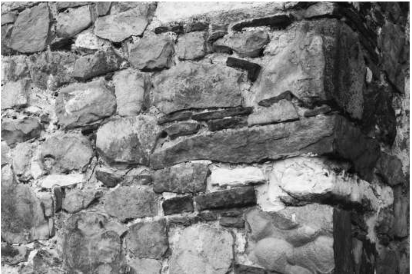
Het Romaanse kerkje (Xe tot XXe eeuw) van Overlaer met de verwerking van Romeinse dakpannen uit de villa van de goudberg in de zijmuren tussen de onregelmatig gekapte kwartsiet en stukken gobertangesteen.
